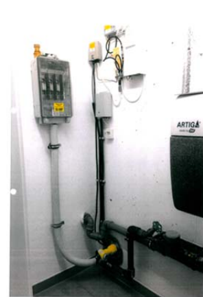
Bildbeispiel: MSHE für Wandeinbau in unterkellerten Gebäuden (Quelle: DOYMA)
